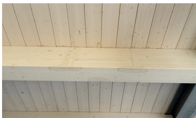
Solai in legno spazzolato dell'Unità 1.
