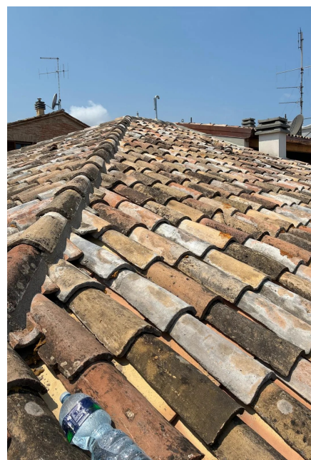
Coppi in buono stato, riutilizzati.
