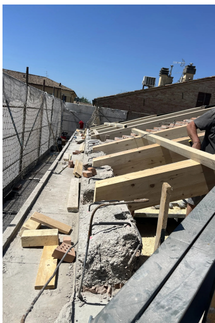
Nuova struttura del tetto.
