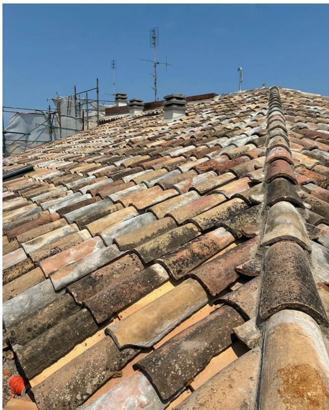
Coppi originali recuperati e rimessi in opera.
